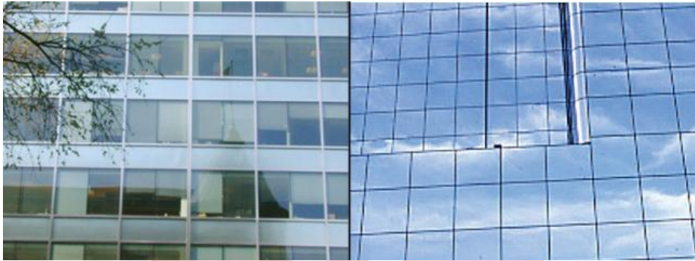
شکل ۱۳ دیوارهای پرده‌ای متداول: سیستم با قاب نمایان (چپ)؛ سیستم با قاب مخفی در پشت شیشه (راست)
