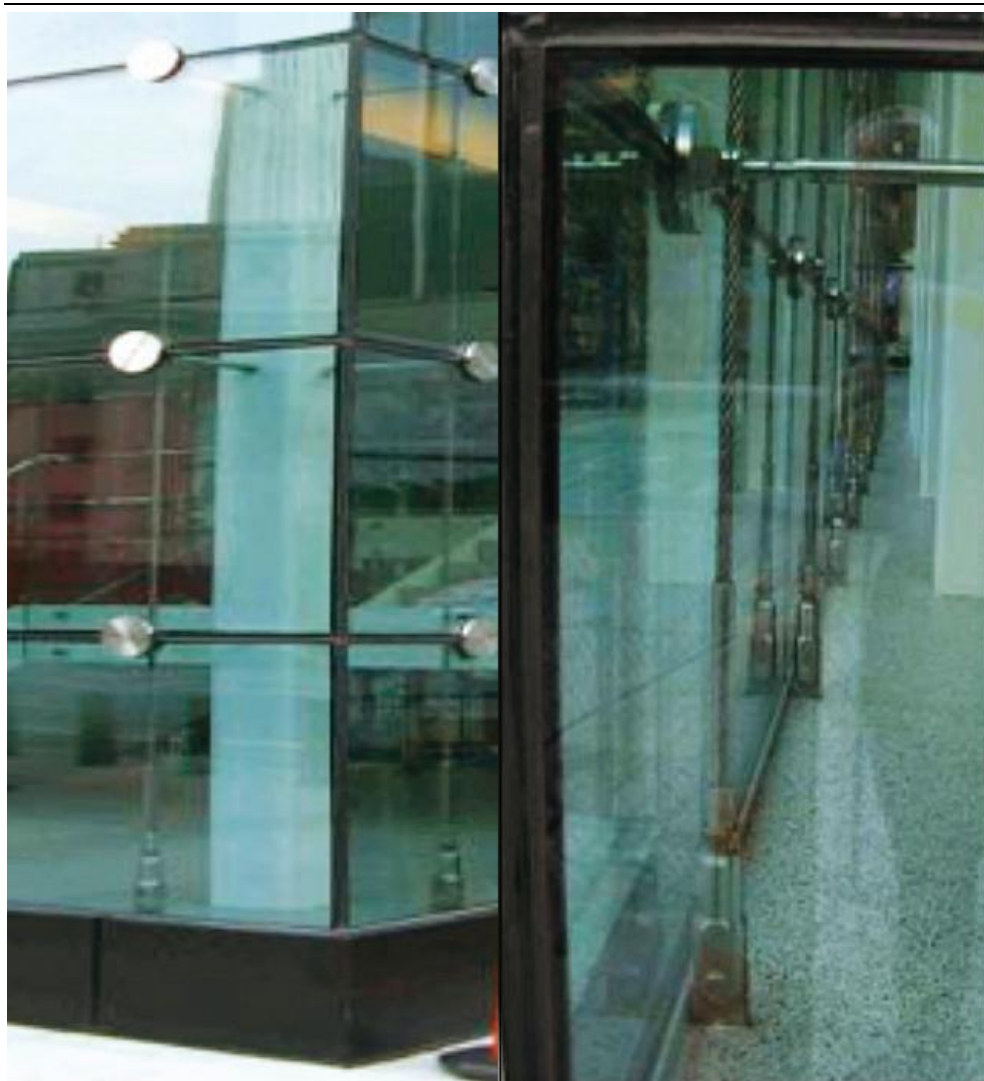
شکل ۲۰ نمونه‌ای از سامانه مهار کابلی
