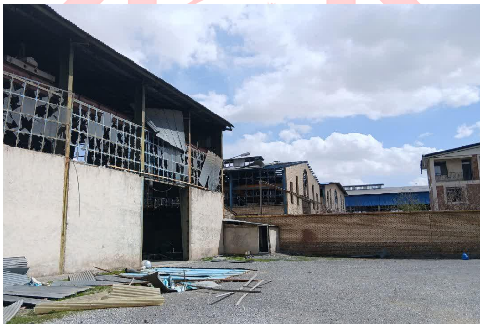
شکل ۶ عملکرد شیشه ها به عنوان ترکش (اراک، فروردین ۱۴۰۵)
